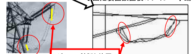
固定装置設置後のジャンパ挙動
