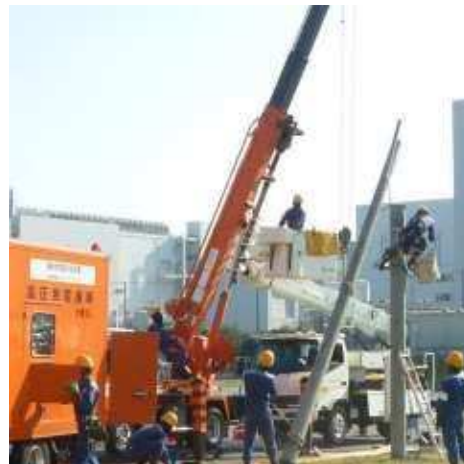
電力設備復旧
