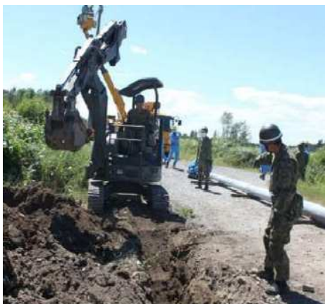
電柱建て込み場所の掘削作業
