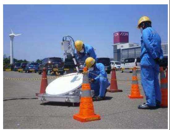
衛星回線を活用した通信回線設置
