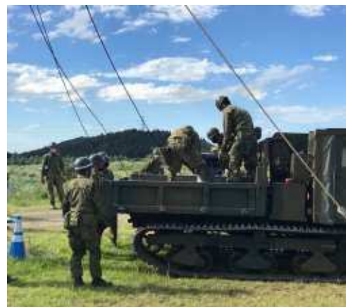
不整地運搬車による変圧器運搬
